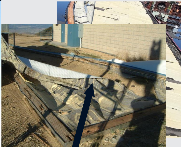
Wood Nailer Edge Failure
